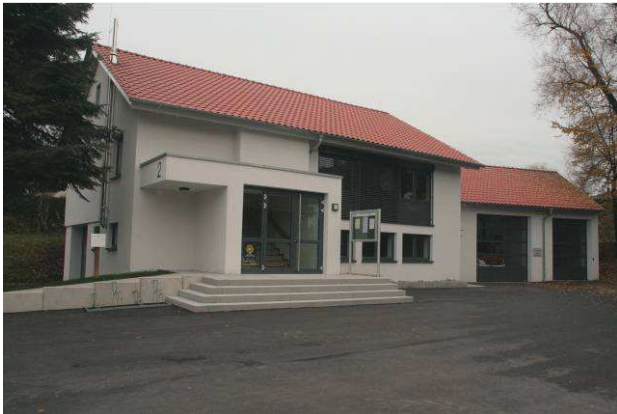
Ortsverwaltung Mettenberg – wurde 2009 grundlegend saniert einschl. Feuerwehrgerätehaus und neuem Feuerwehrfahrzeug
